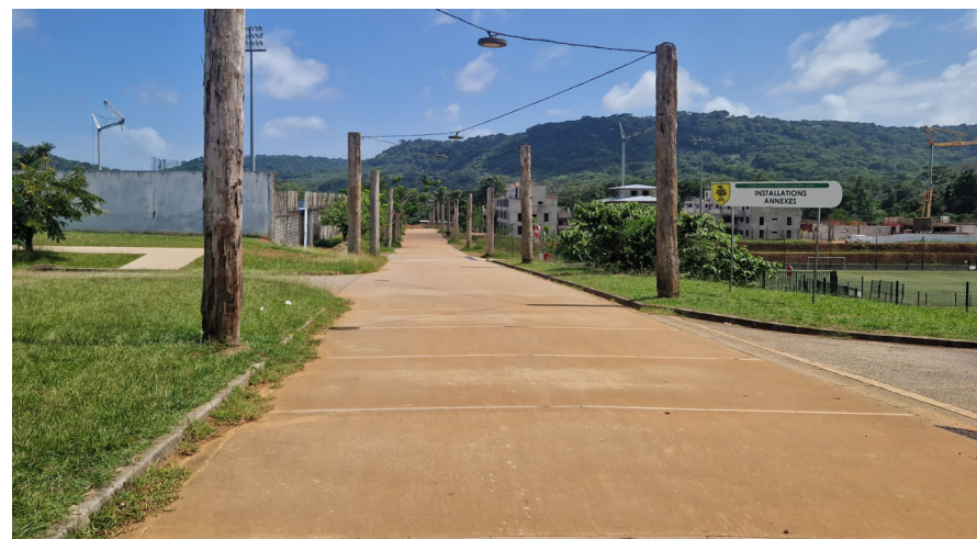
Voiries de l'écoquartier G. Othily à Rémiré-Montjoly - Réutilisation de la terre du site pour les revêtements de sol
