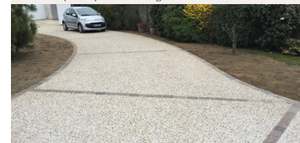
Voie carrossable en béton clair © Pavex
