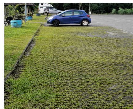
Parking en dalles alvéolaires enherbées à Montsinéry
