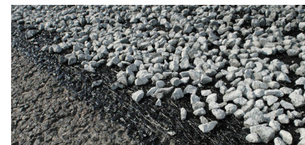
Bitume et gravier © COLAS / Erwann Le Gars
